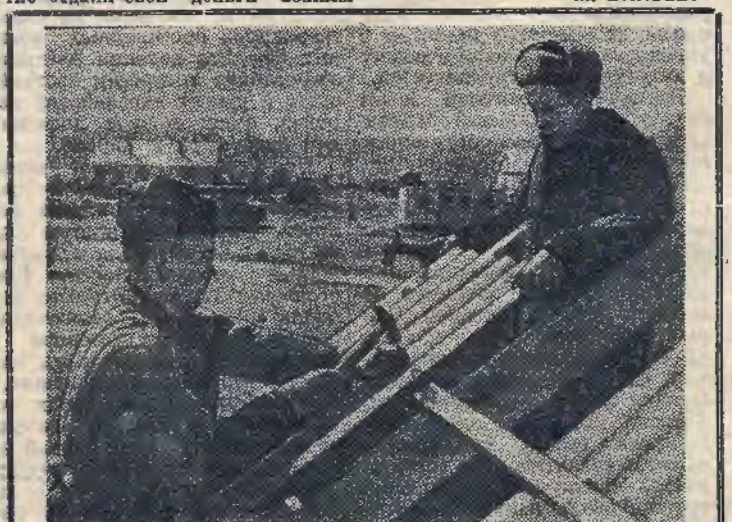
Казахская ССР. В числе первых новоселов прибыл по комсомольской путевке в совхоз «Жана-Аульский» (Павлодарская область) столяр из Ставрополя Илья Помагаев. Здесь он возглавил бригаду строителей.
