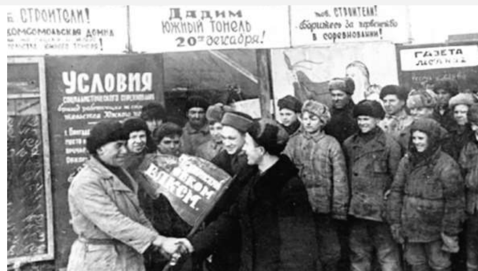
Вручение знамени обкома строителям домны, 1943 г. Знамя принимает Виктор Тяжелников / ФОТО: ОТКРЫТЫЕ ИСТОЧНИКИ
