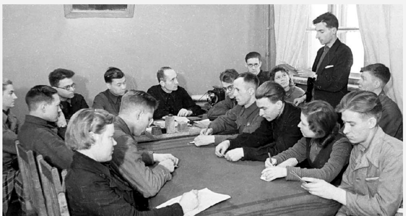
Заседание комсомольского штаба строительства домны, 1943 г. Виктор Тяжелников за столом четвертый справа / ФОТО: ОТКРЫТЫЕ ИСТОЧНИКИ
