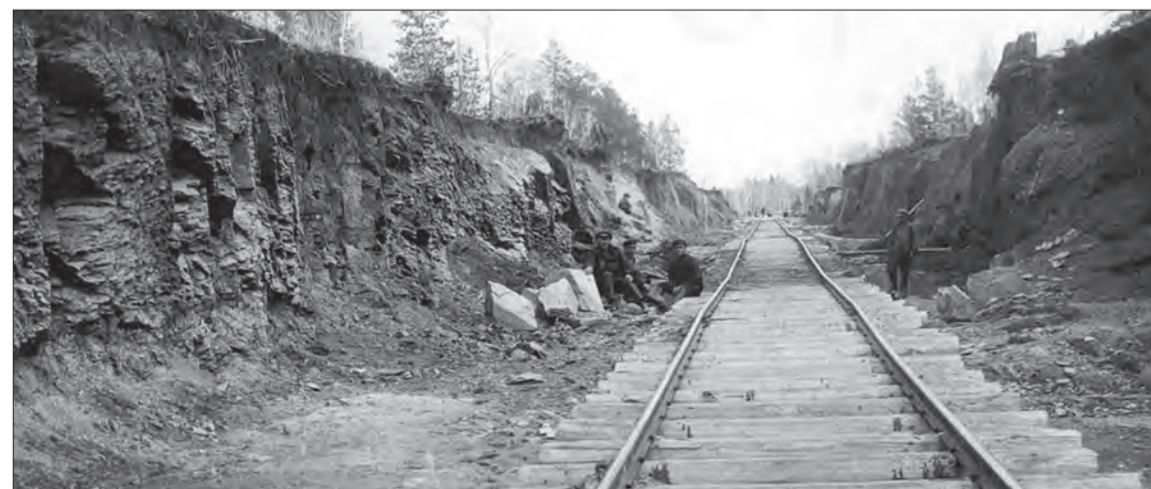
Строительство железнодорожной ветки Карталы – Магнитогорск
