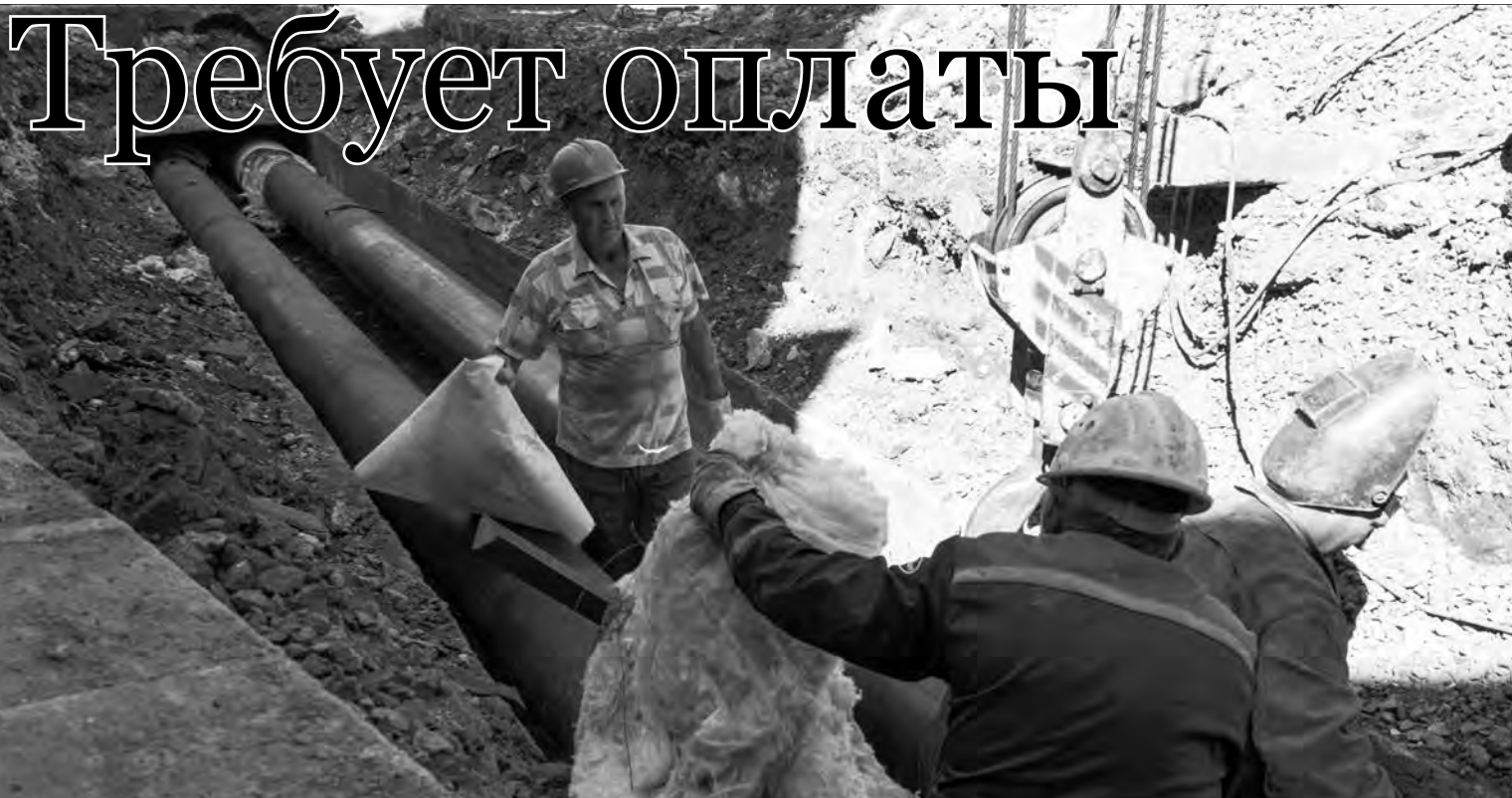
15 км трубопроводов тепловой сети и сетей горячего водоснабжения отремонтировали теплофикаторы в 2017 году
