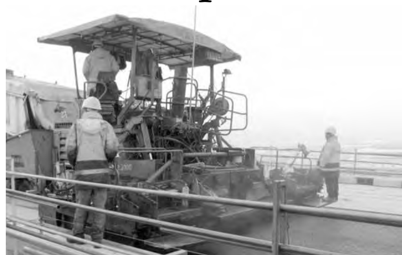
● Рассматривается вопрос о принятии региональных стандартов дорожного строительства
