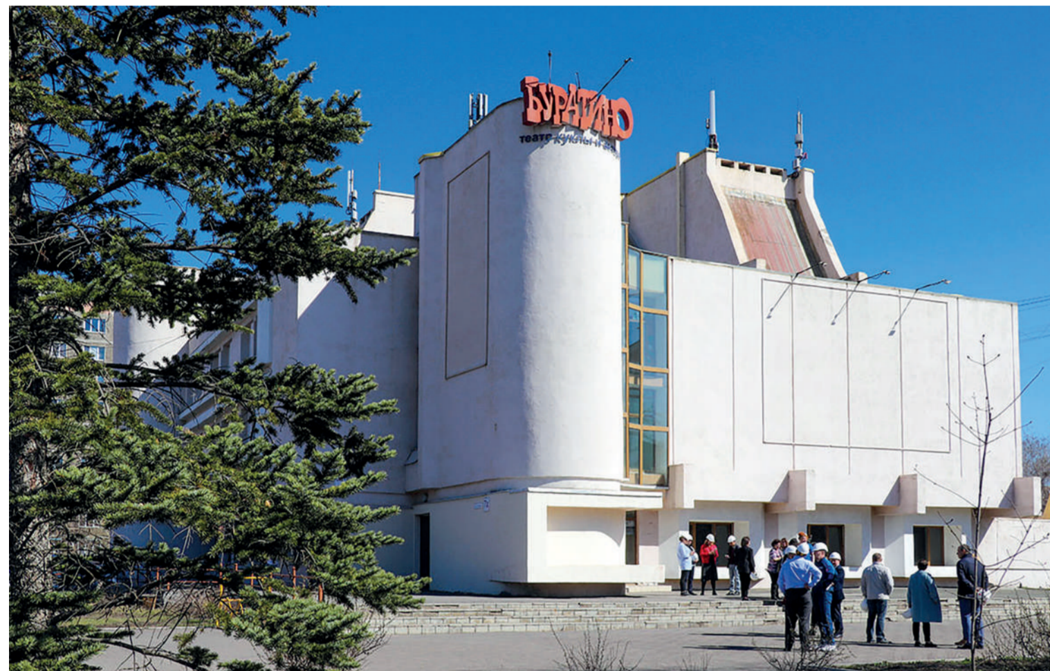
Благодаря нацпроекту капитальный ремонт и модернизация проходят в театре «Буратино»
