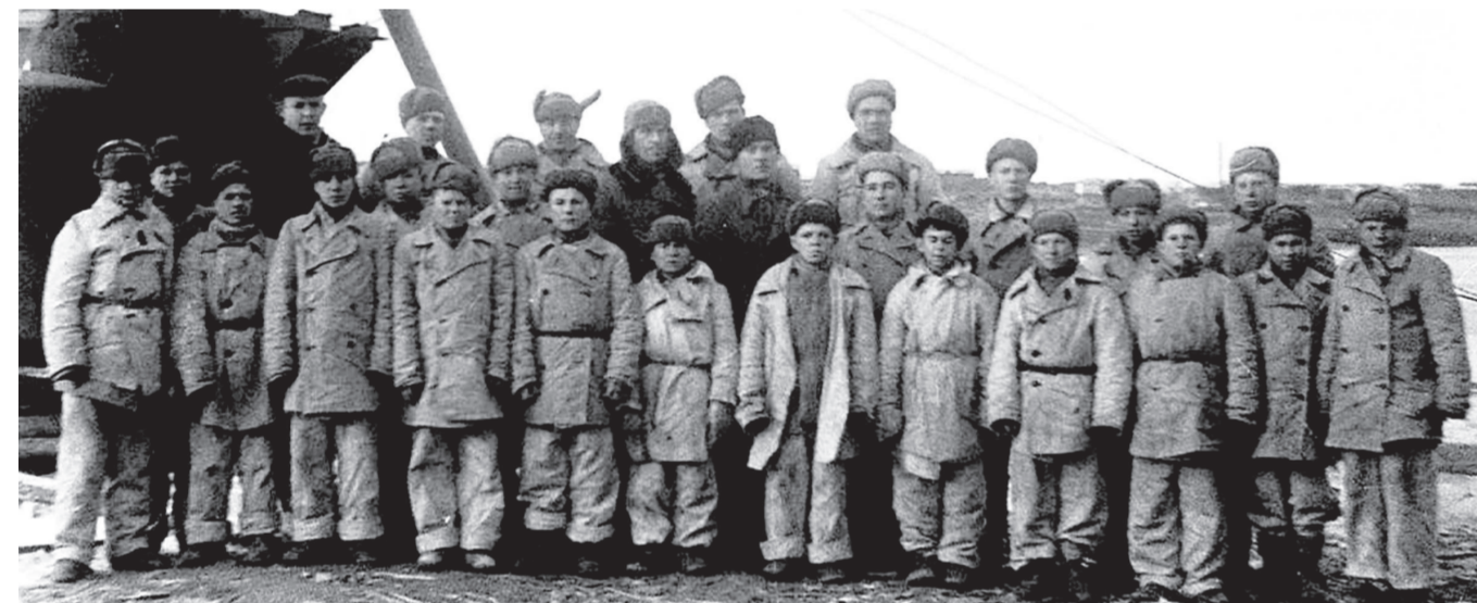
Фронтная бригада строителей
